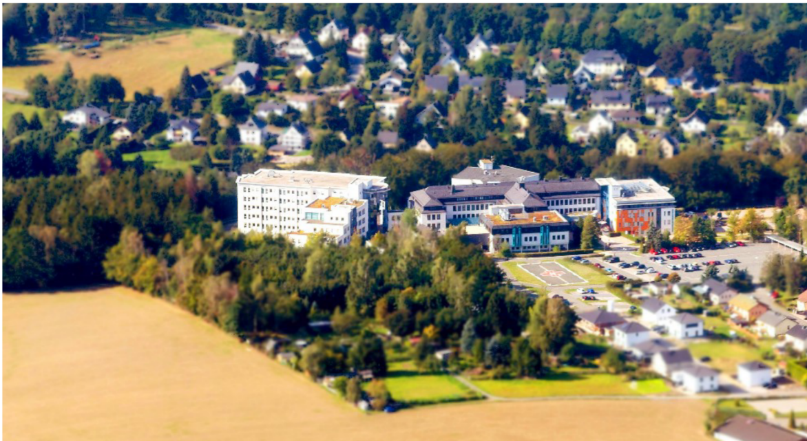
Luftbildaufnahme Klinikum Obergöltzsch Rodewisch
